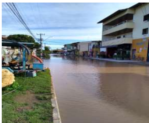
Figura 2 - Alagamento na Avenida Praiano, Guriri, ES
